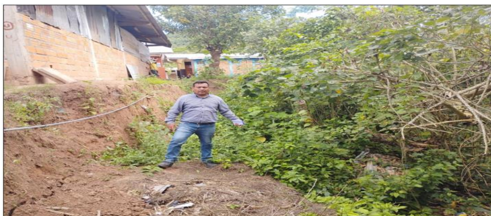
FIGURA N°02: TRAMO CRÍTICO DE LA QUEBRADA QUINAYACU, DONDE SE PUEDE APRECIAR LA EROSION DEL TALUD, CON RAJAMIENTO PROPENSO A COLAPSAR AFECTANDO A LAS UNIDADES PRODUCTIVAS Y PROBLACION DEL SECTOR.
